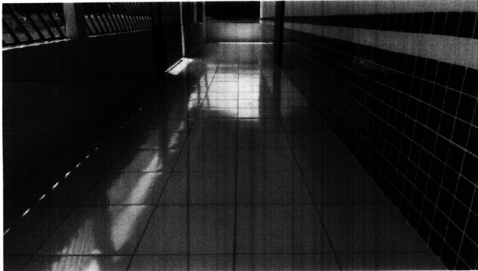
Foto 06 – Piso Cerâmico varanda
