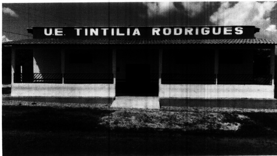
Foto 07 – instalação de gradil de proteção e portão
